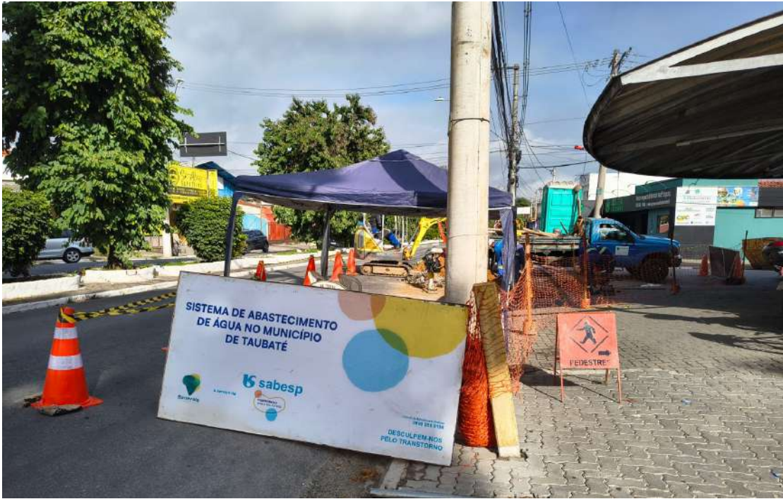
Obras acontecem em vários pontos da cidade de Taubaté
